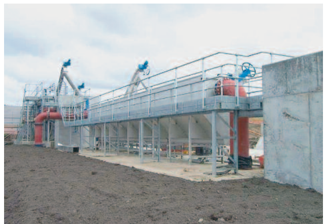
Maan päälle asennettu ROTAMAT® Suorakaiteenmuotoinen hiekanerotin Ro 6, ja erottimen edessä välppäys
