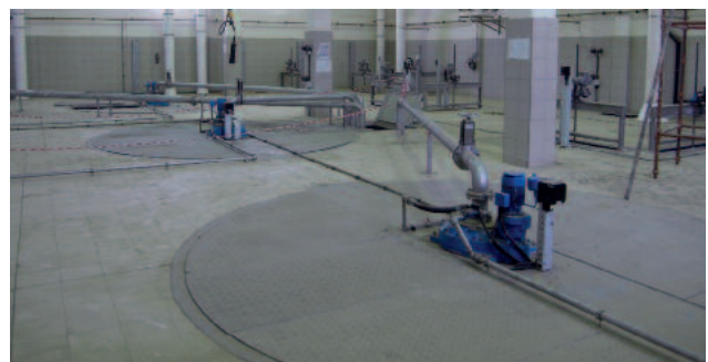
HUBER VORMAX asennus ennen käyttöönottoa
