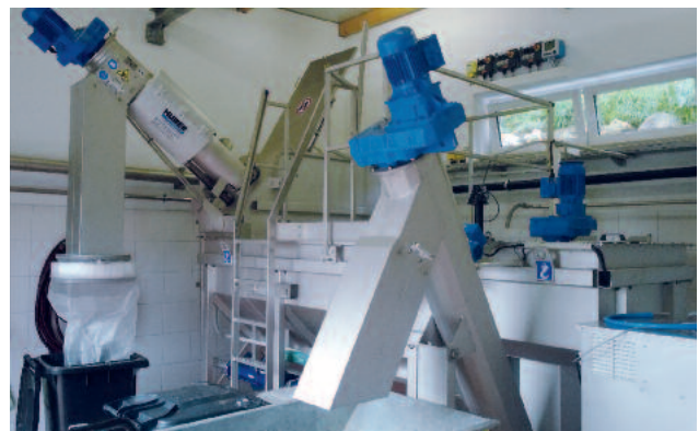
Kompaktilaite, jossa sisäänrakennettu hiekanpesuri
