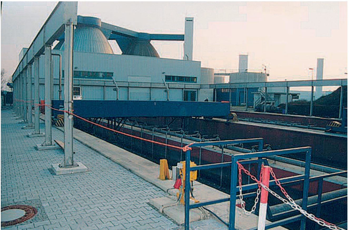
Tyypillinen suorakaiteenmuotoinen hiekanerotin imutyhjennyksellä (JVP Mannheim)
