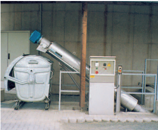
Ulos asennettu ROTAMAT® Ro 9 ruuvivälppä
