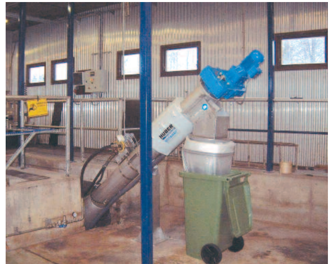
ROTAMAT® Ruuvivälppä Ro 9 koko 700 asennettu kanavaan
